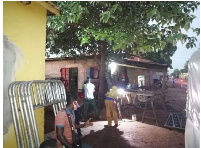
Fabrication des lits: soudure des sommiers
