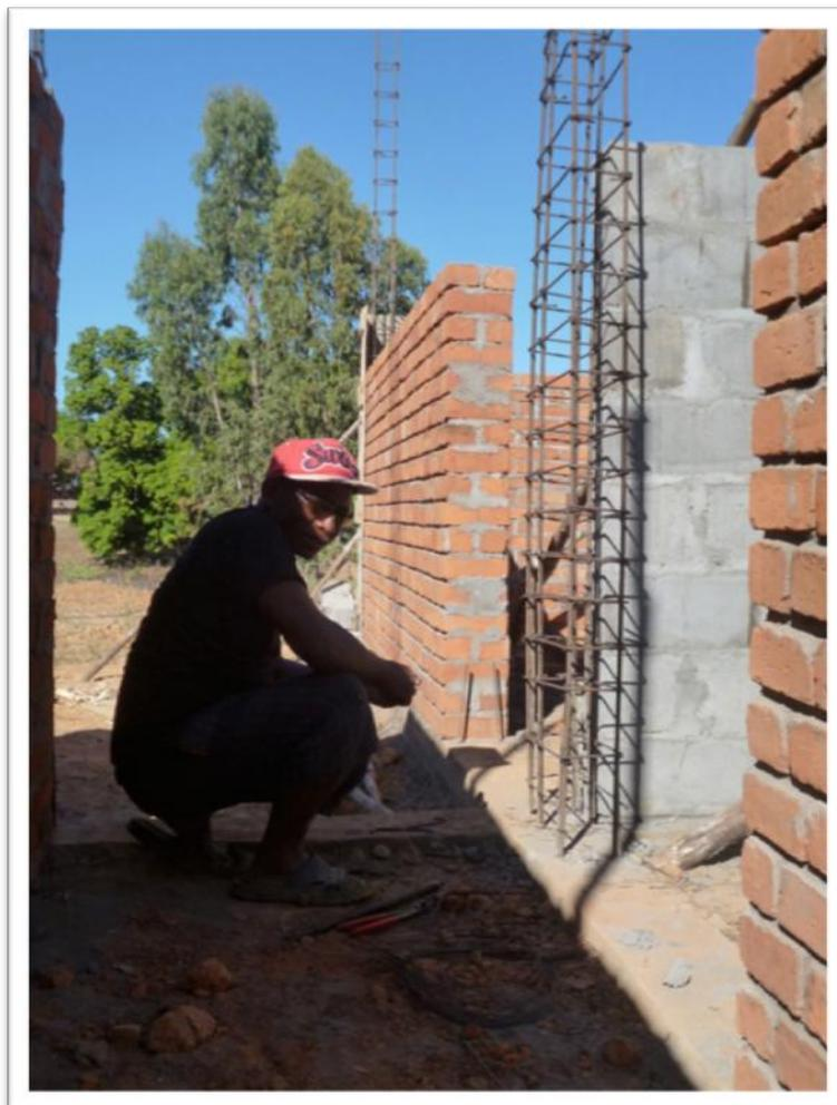
Prochaines étapes, élévation des murs jusqu'à 2,50 m, coulage du chaînage (poutres horizontales), et pose des cadres des fenêtres et des portes.
